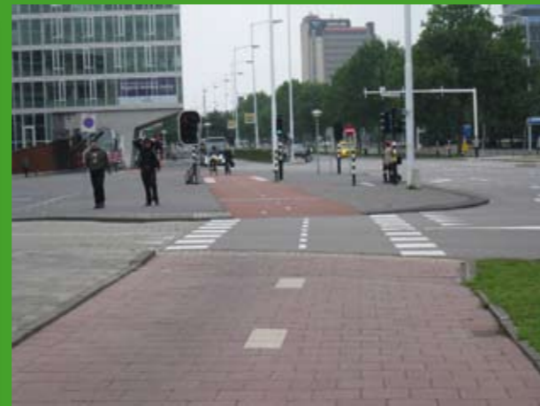
Het rode fietspad is niet doorgetrokken
