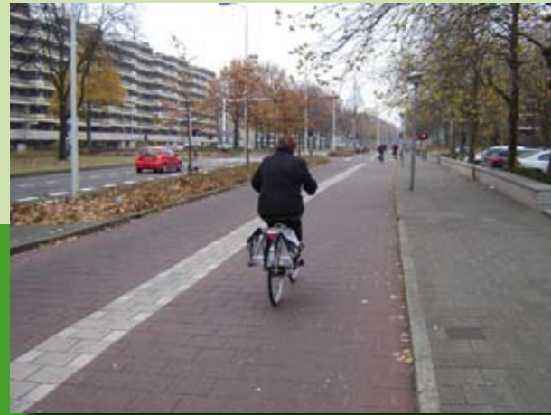
Tegelverharding fietst niet comfortabel
