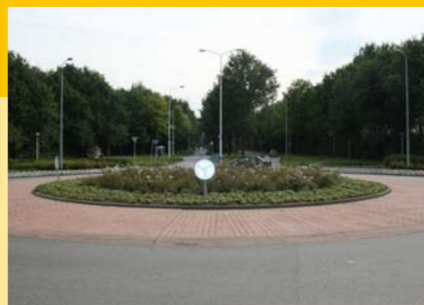
Betere doorstroming voor fietsers door een kruispunt met verkeerslichten te vervangen door een rotonde
